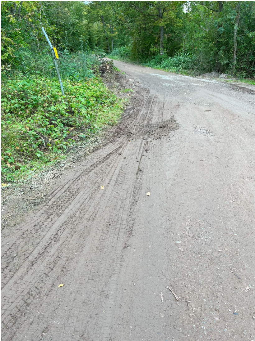
Körskador på väg i samband med körning av lastbilar och flishugg.
