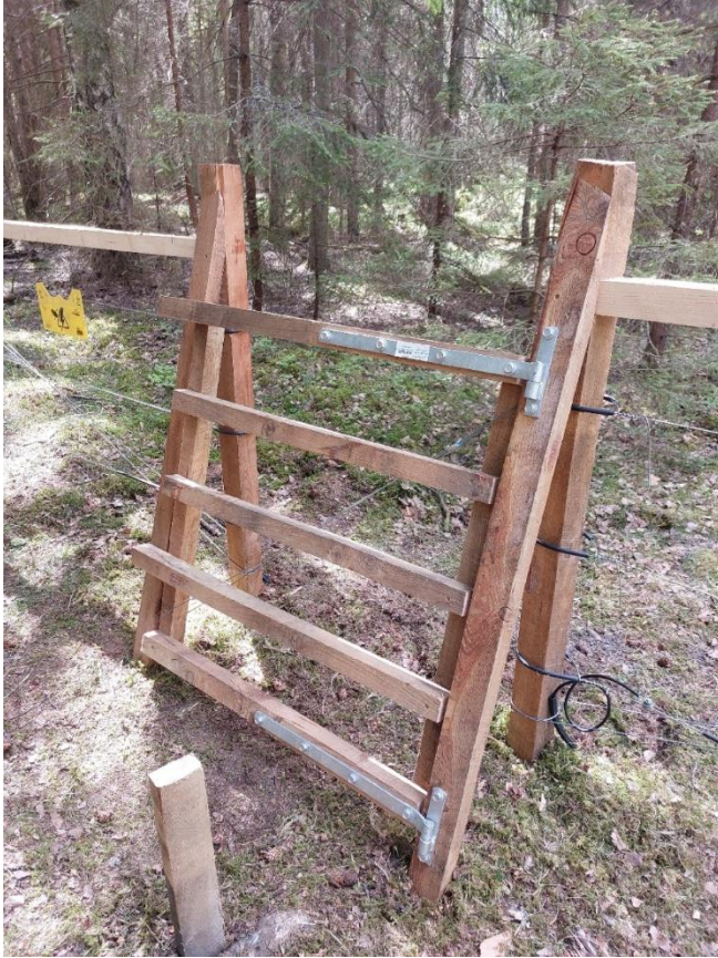
Bild 12. Bilden visar en ny självstängande grind. LIFE-bricka saknas fortfarande men ska fästas snart. Foto: Sari Roponen 2023-06-02 (ObjektID 16037).
