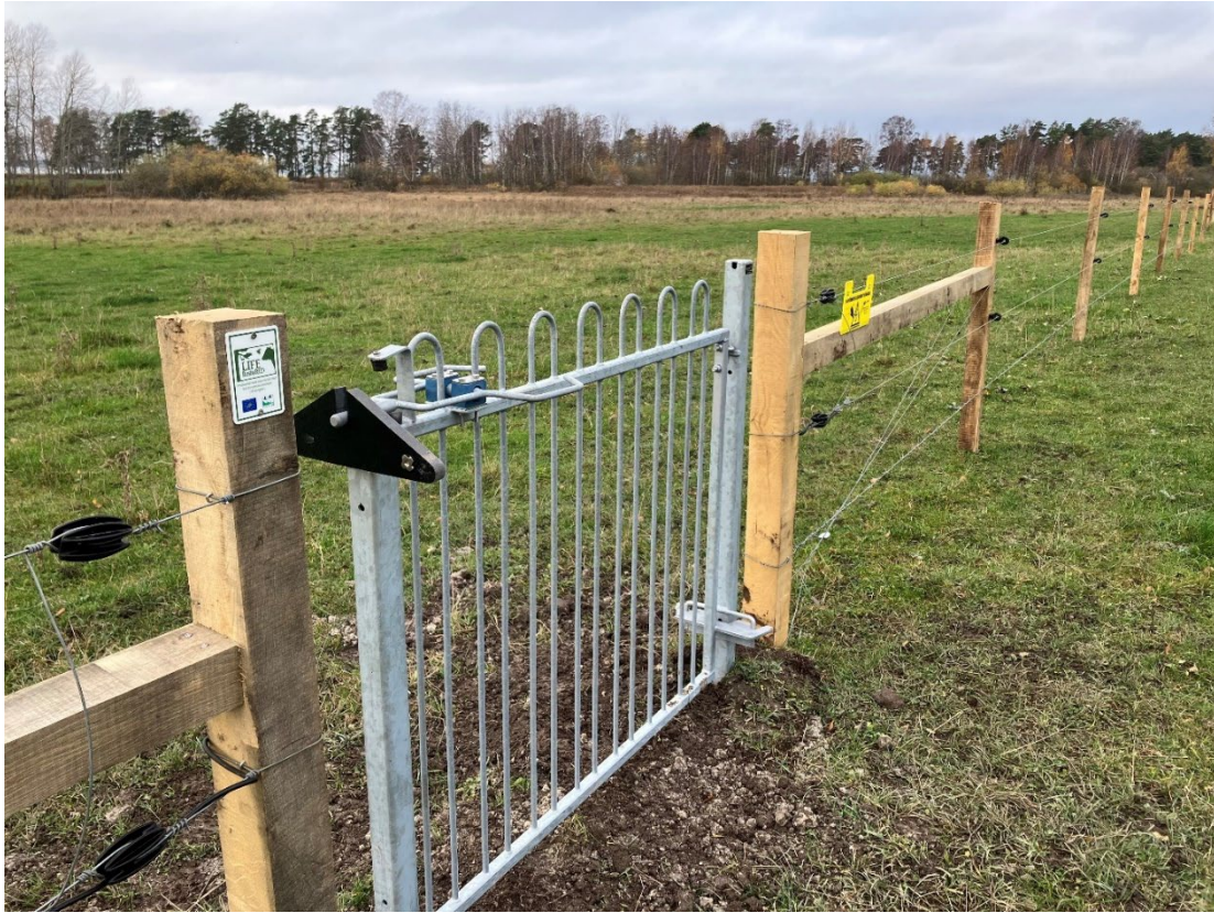
Figur 16. Nytt stängsel och självstängande grind mellan ytan som ska schaktas och det befintliga rikkärrsområdet, foto taget november 2022. Fotograf: Lisa Andersson
