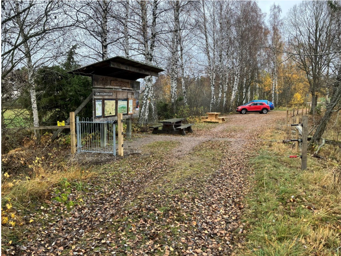
Figur 17. Nytt stängsel och nya grindar mot parkering och entré, foto taget november 2022. Fotograf: Lisa Andersson
