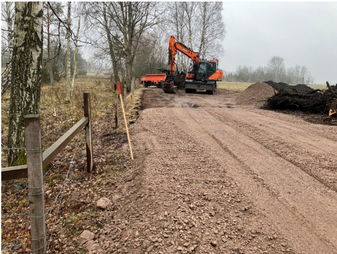
Figur 12. Arbete pågår med att stärka upp vägen och utöka parkeringen. Mars 2024. Foto: Lisa Andersson
