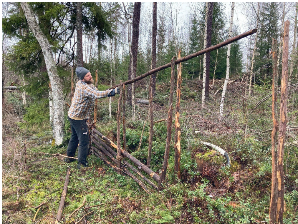
Byggnation av trögärdesgård för att avgränsa slätterängen mot skogen. Foto: Ellen Flygare.
